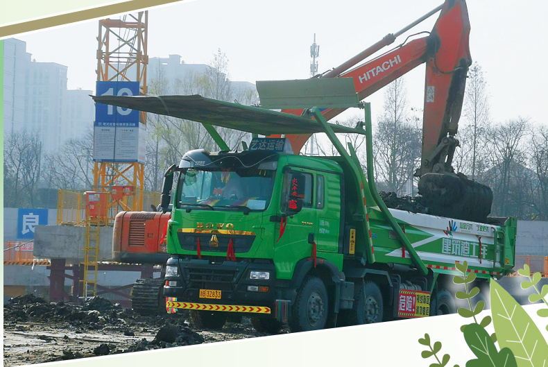
工地渣土装运现场。(杨绪忠 摄)
