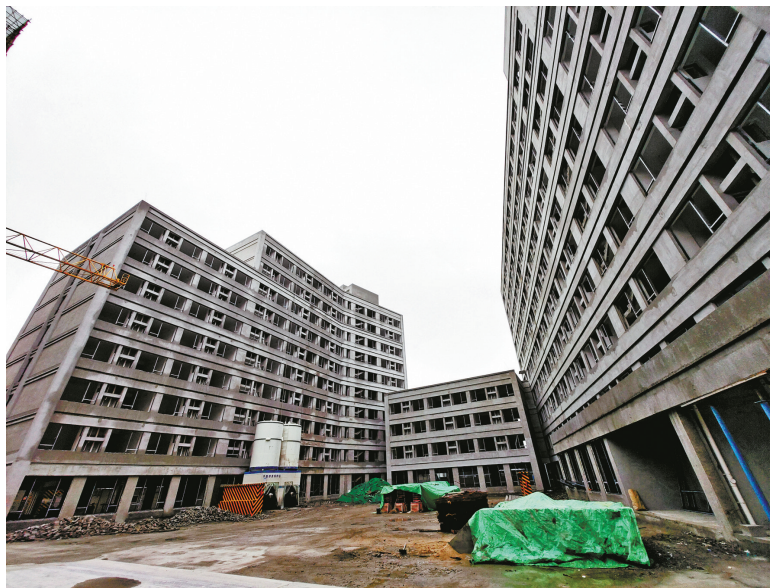
蓝领公寓（暂名）已结顶。（沈孙晖 摄）
