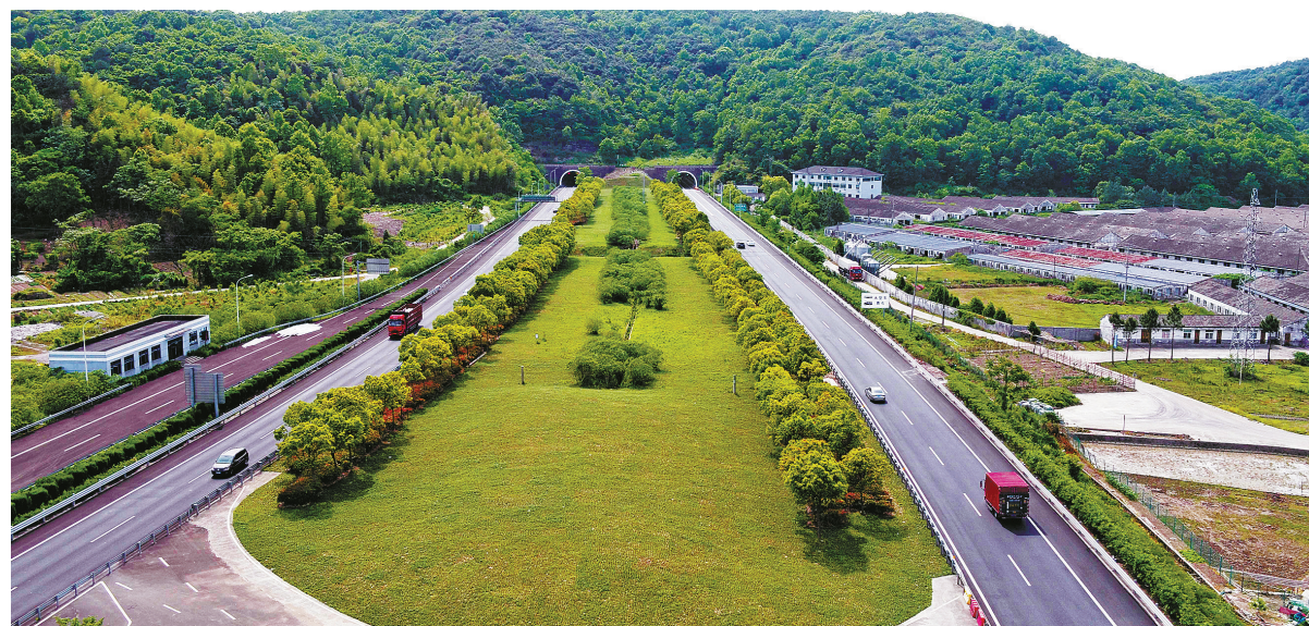
甬莞高速象山港大桥及接线。
