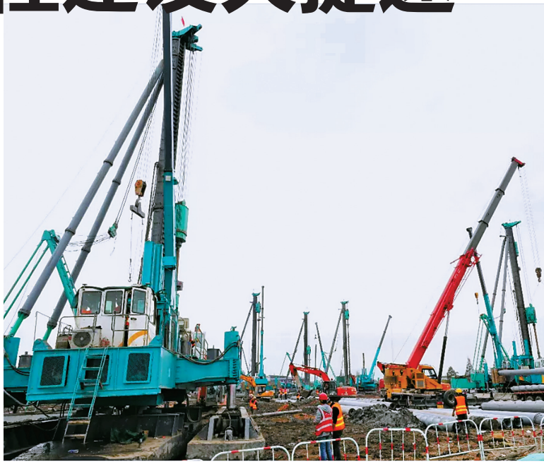
为确保市康养养护中心这一民生工程早日建成投用，市城投公司施工团队24小时不间断作业。（徐欣 李云苗 摄）
