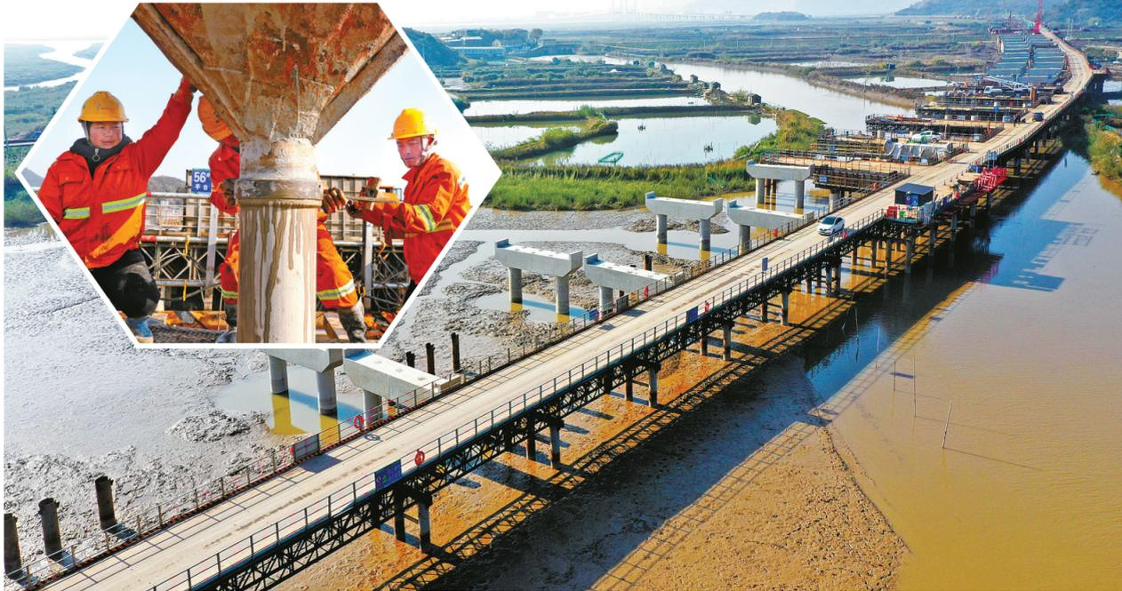
在位于宁海县的G228一市港特大桥建设现场，施工人员正在安装灌梁斗，为桥桩灌梁作准备。一市港特大桥全长3.38千米，起点在新山村，跨越一市港水库大坝，连接旗门港大桥北引桥。该项目建成后，对完善省道主干公路网络及宁波市和宁海县公路干线交通网络、加强宁海与台州两地基础设施的互联互通、加快推进甬台合作示范区建设、促进“环三门湾”区域开发等具有重要意义。（李江林 严龙 摄）
