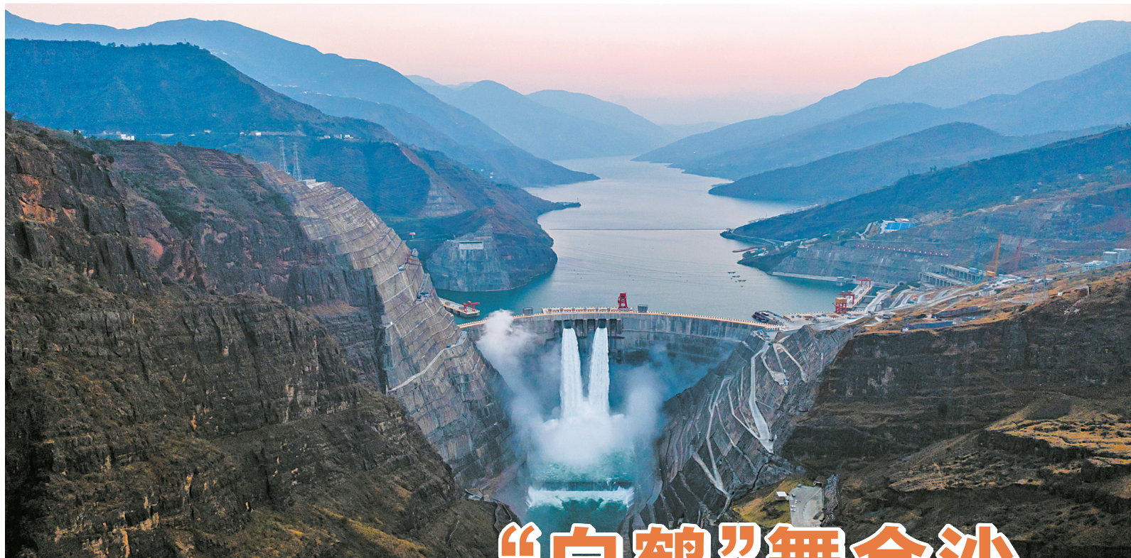
白鹤滩水电站一景(12月19日摄,无人机照片)。
