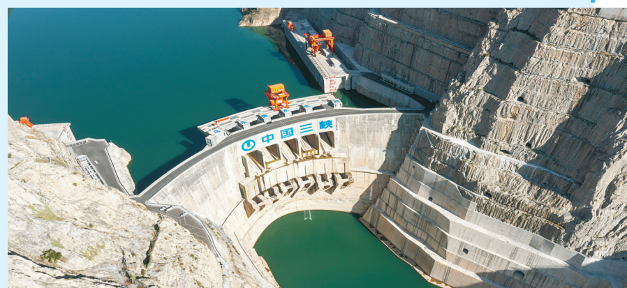
这是11月25日拍摄的乌东德水电站(无人机照片)。
