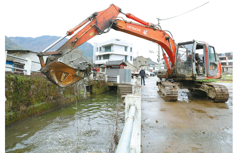
疏浚工程现场。
