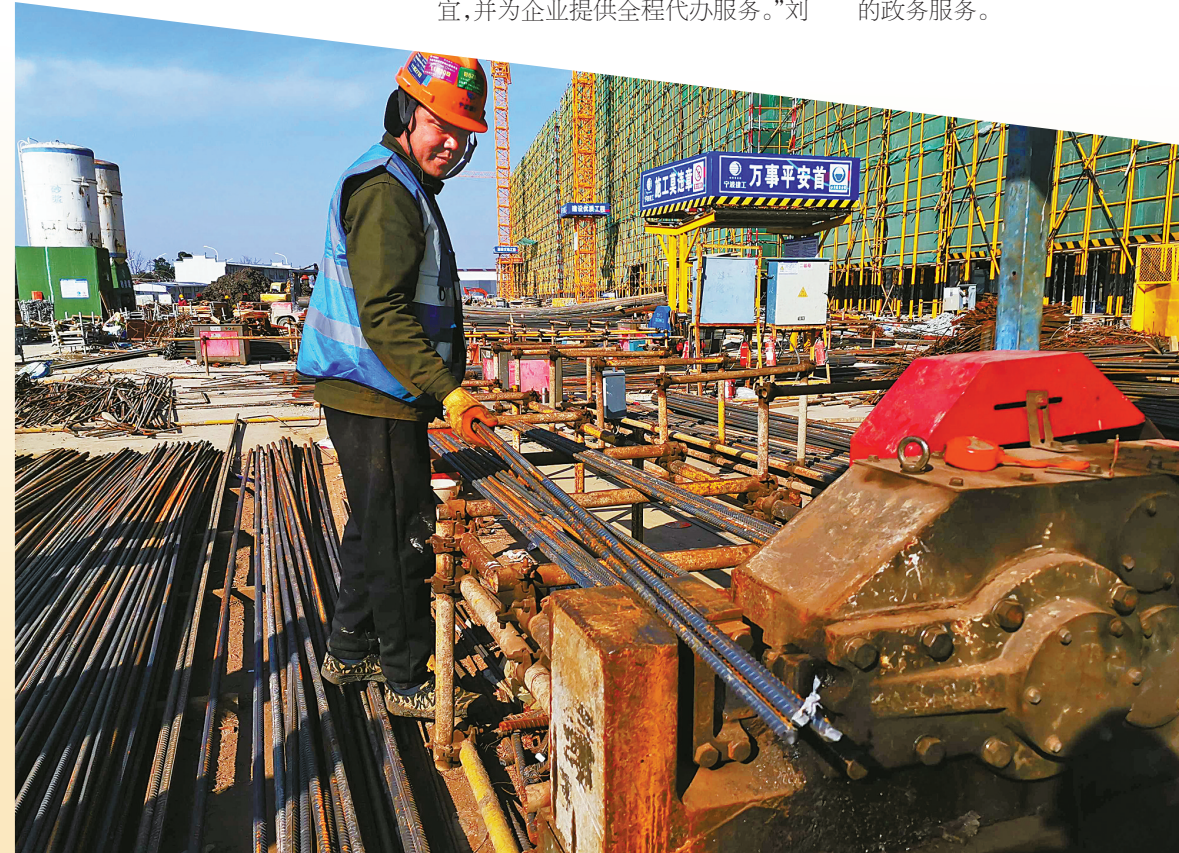
宁波市康养护理中心建设项目施工现场。(余建文 摄)
