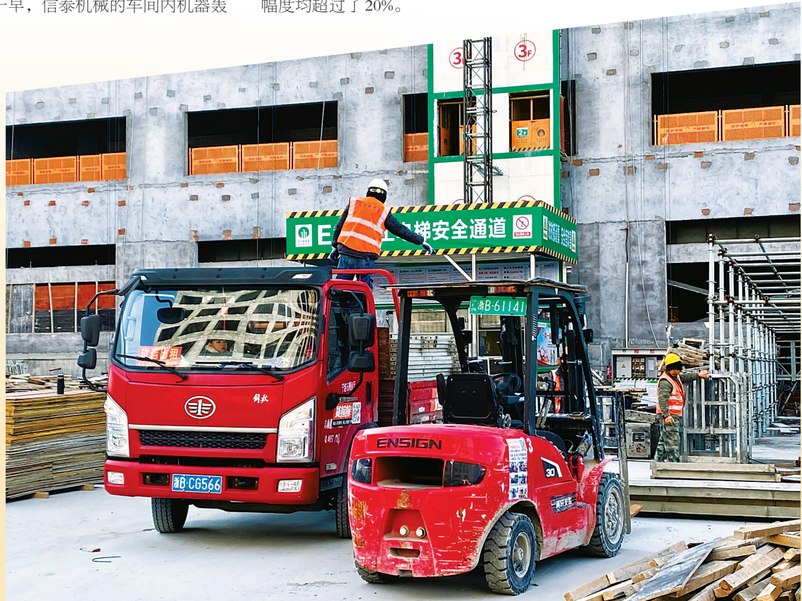
甬江实验室建筑工地。(李芮 摄)
