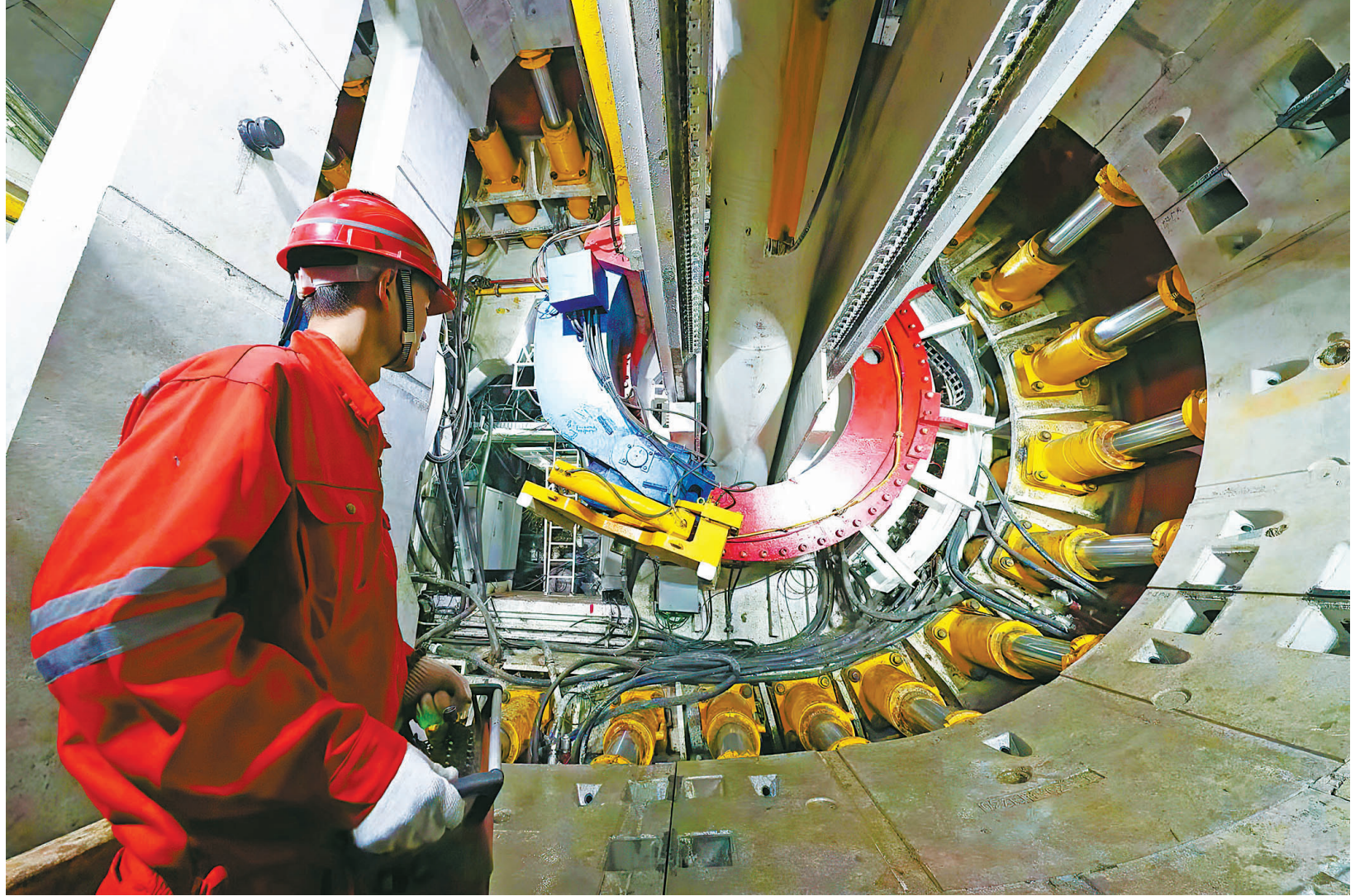
▲新春佳节，我市各重点工程建设现场热火朝天。图为轨道交通8号线明州医院站-庙堰站区间盾构正在加快掘进，这是宁波轨道交通第三期建设项目首台始发的盾构机，标志着第三期建设开始进入隧道区间施工。（张培坚 摄）
