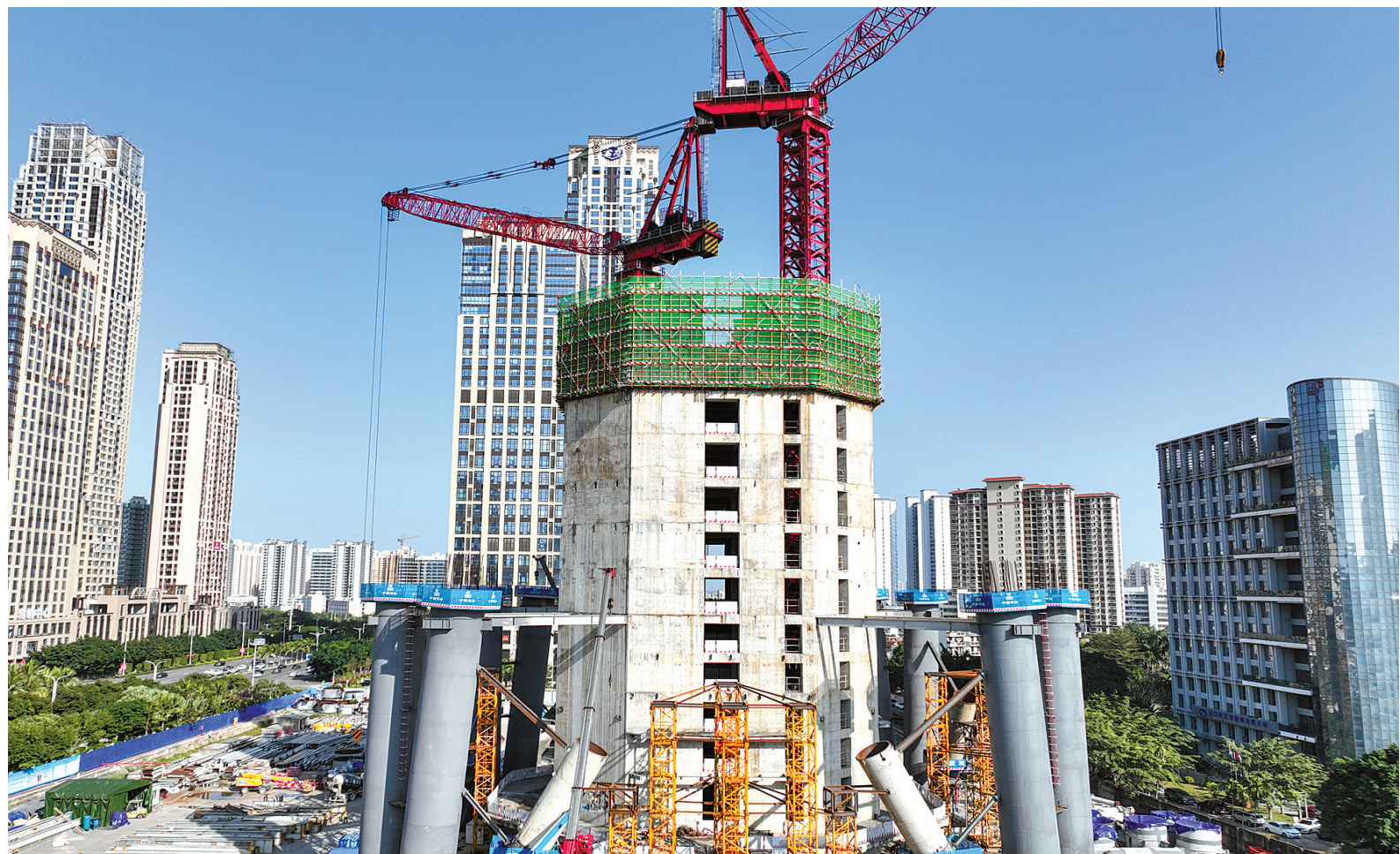
1月30日拍摄的海南中心项目工地（无人机照片）。新年伊始，在由海南机场投资建设、中建三局承建的海南中心项目工地上，工人们抢抓工期，现场一派繁忙的景象。海南中心项目总投资近百亿元，建筑高度428米，主体塔楼94层，预计2025年底项目主体结构封顶、2026年底投入运营。项目建成后将成为海南第一高楼。（新华社发）
