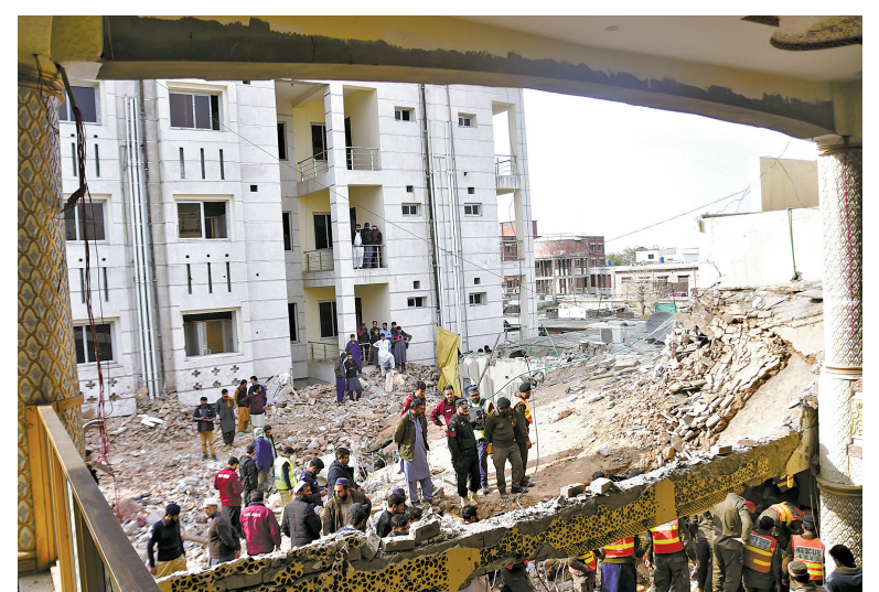
1月31日,在巴基斯坦白沙瓦,救援人员和安人员查看爆炸袭击现场。(新华社发) 新华社伊斯兰堡1月31日电 巴基斯坦当地医院1月31日确认,该国西北部开伯尔-普什图省首府白沙瓦市30日发生的清真寺爆炸袭击事件造成的死亡人数升至100人,另有200人受伤。 白沙瓦警方官员穆罕默德·伊贾兹告诉新华社记者,初步调查显示这是一起自杀式爆炸袭击事件。事发时,清真寺内有350多人。爆炸导致清真寺坍塌,救援人员31日在废墟下找到更多遇难者遗体。目前搜救工作仍在进行。
