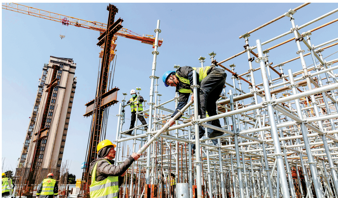
工人抓紧施工。
