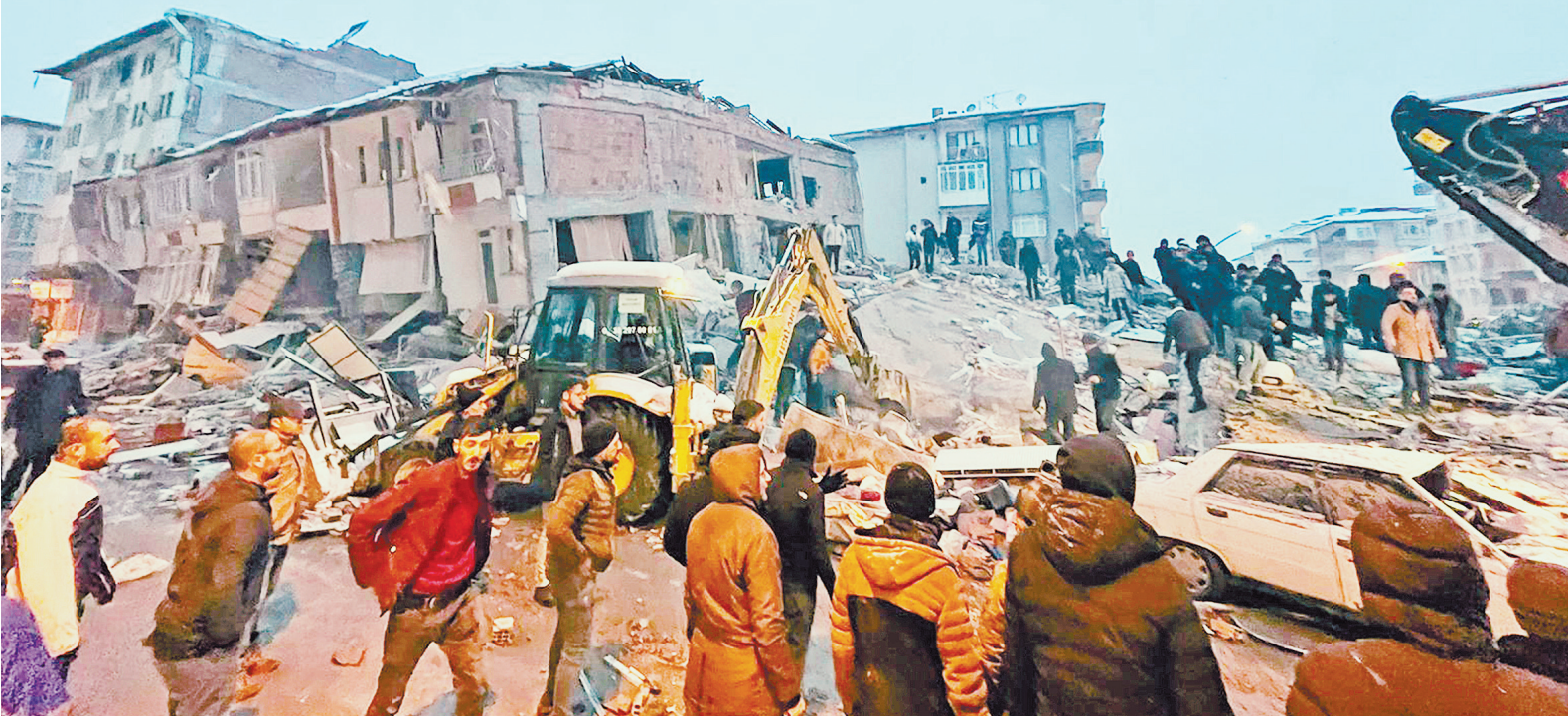
2月6日，人们聚集在土耳其马拉蒂亚一处倒塌的建筑附近。
