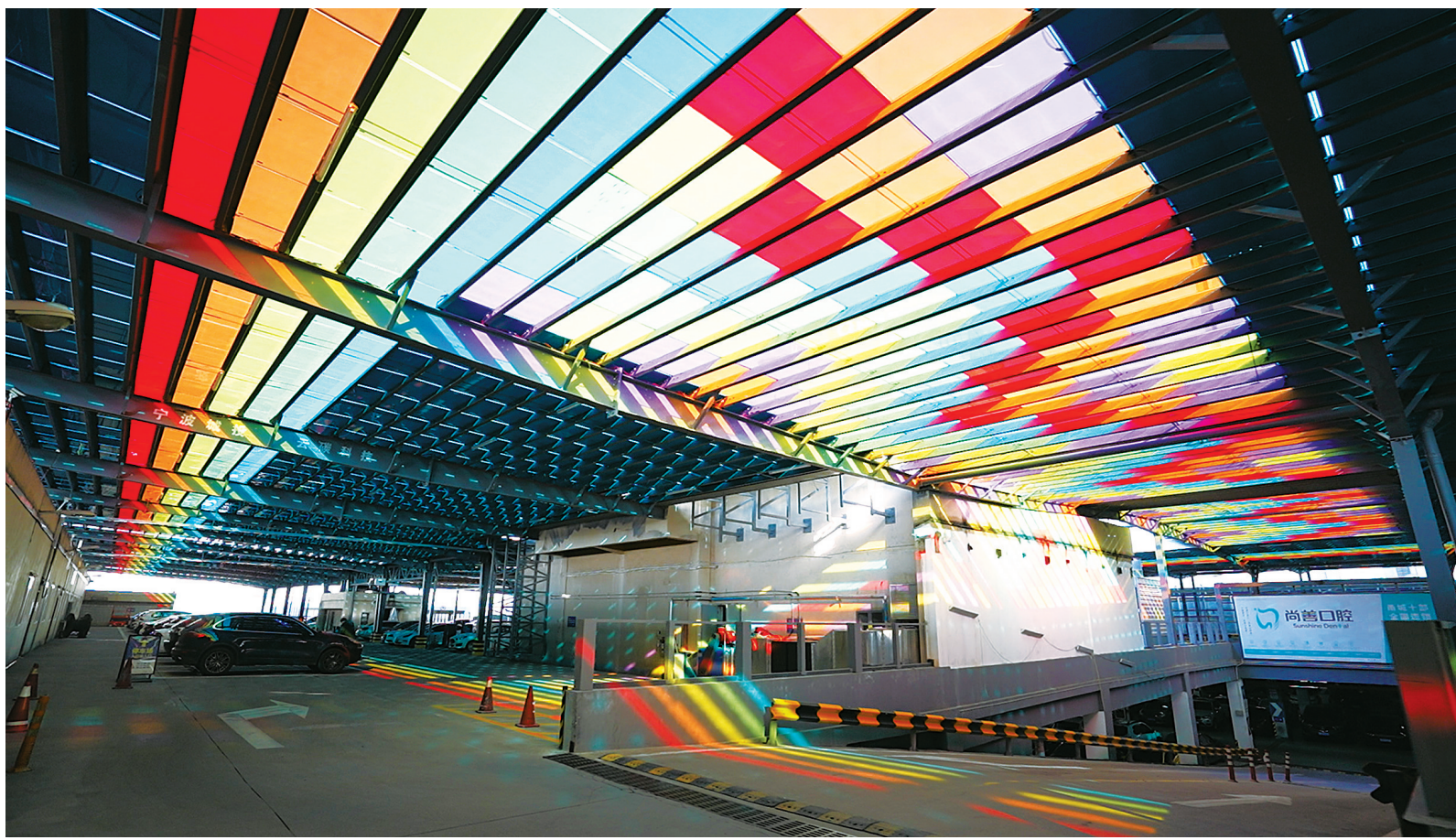
建成投用后的天一广场停车楼光伏项目。
