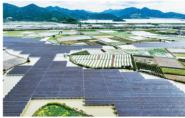
我市持续推进低碳建设，图为宁海县长街镇城塘村“渔光互补”发电项目。（严龙 摄）
