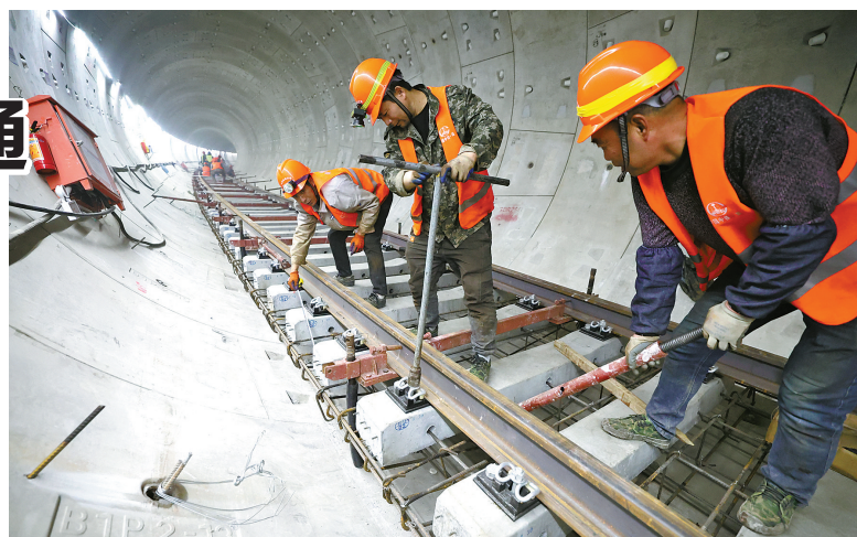
工人正在施工。
