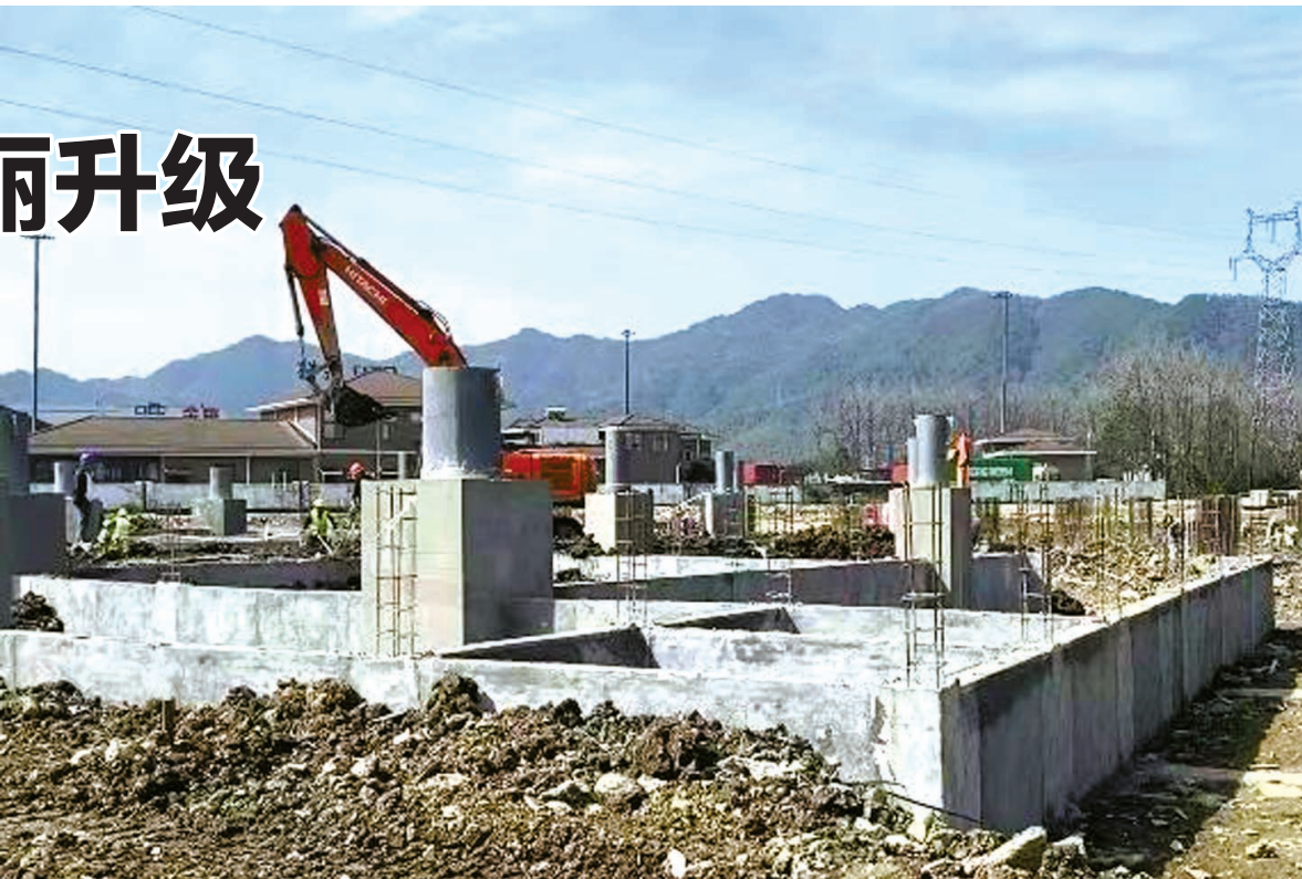
余姚服务区(杭州方向)增扩建现场。
