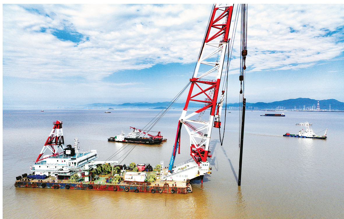
昨天，“铁建桩01”轮将首根平台桩打入海中。
