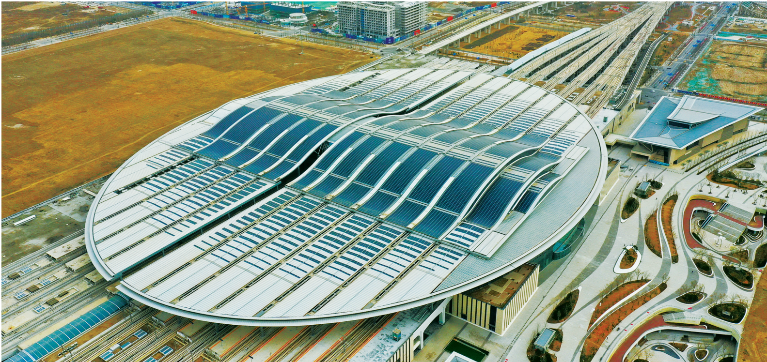
图为3月23日拍摄的京雄城际铁路雄安站(无人机照片)。
