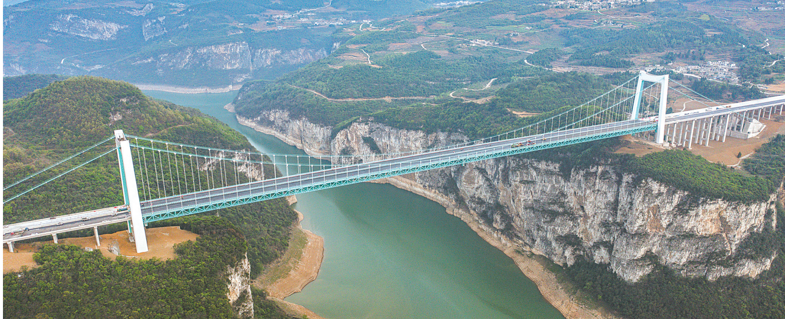
这是建设中的金峰乌江大桥(无人机照片,4月3日摄)。近日,贵金古(贵阳经金沙至古蔺)高速金峰乌江大桥建设项目已全面进入桥面铺装施工阶段。金峰乌江大桥是贵金古高速公路项目的重要控制性工程,桥梁全长1473.5米。
