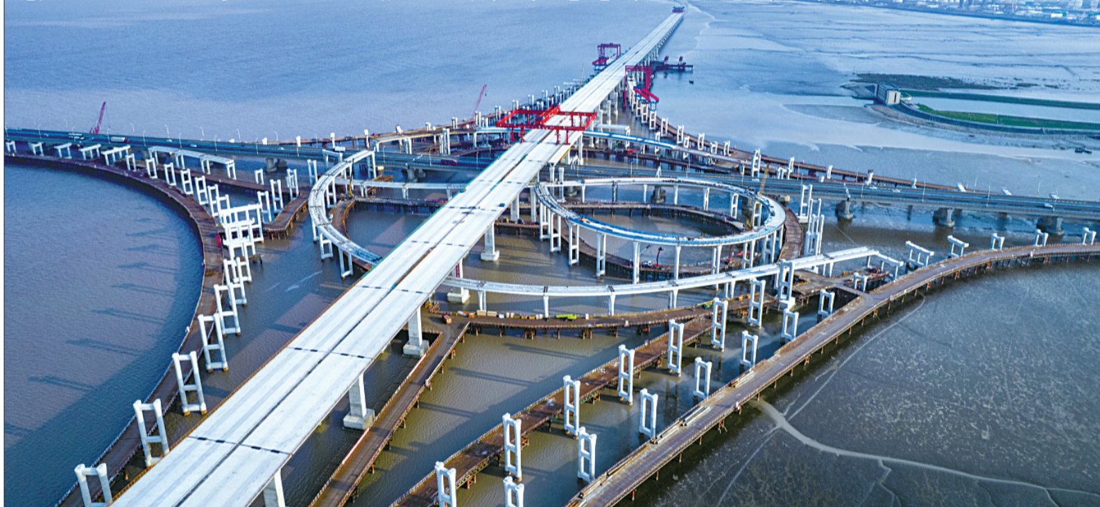
杭甬高速复线宁波一期项目滨海互通施工现场。
