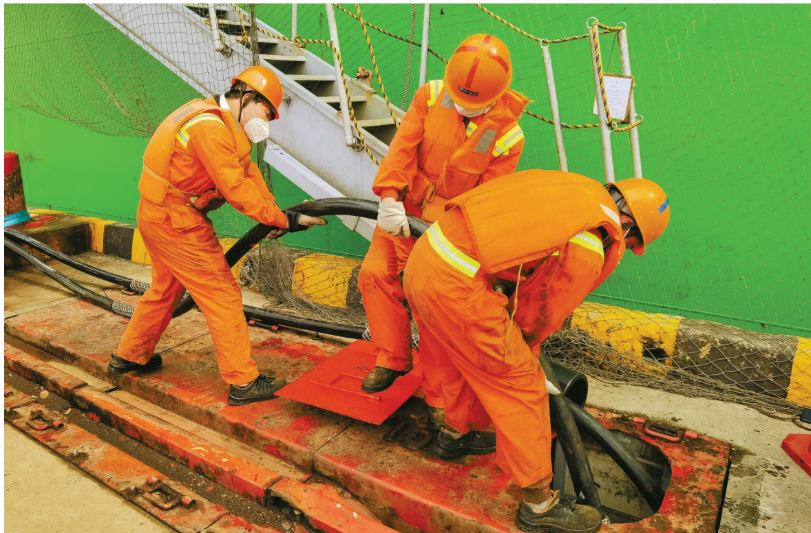
工作人员正扶着电缆进行接线操作。
