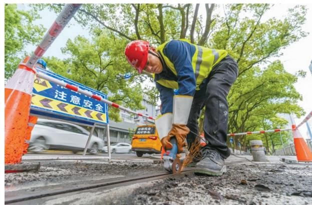
4月21日上午，海曙区市政养护中心工作人员在长春路天一桥安装伸缩缝免维护装置，排除安全隐患。
