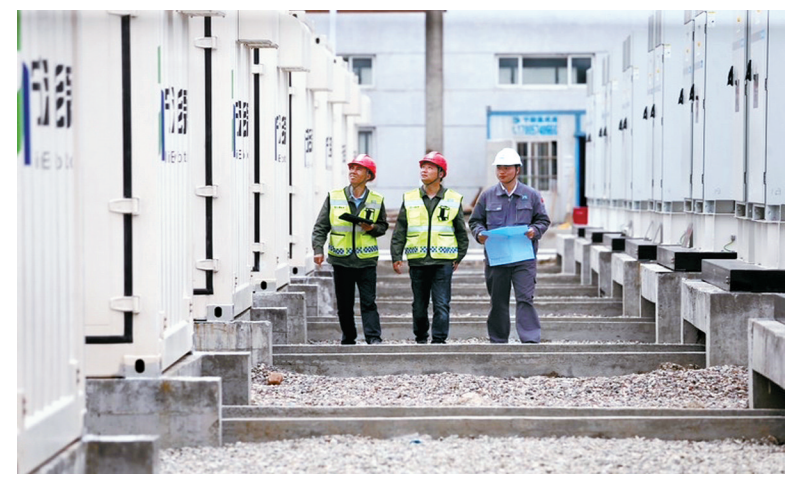
朗辰储能电站项目现场。(王幕宾 摄)
