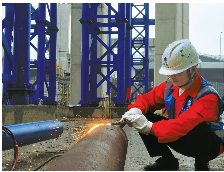
宋光照在组装钢结构箱型立柱。（王博 陈锡川 摄）
