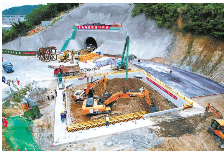
金塘海底隧道宁波段盾构工作井施工现场。(中铁十四局供图)
