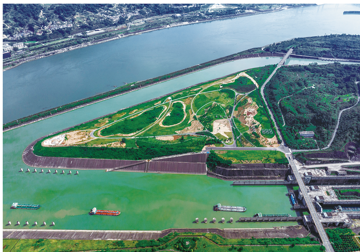
6月9日，船舶即将进入三峡大坝五级船闸（无人机照片）。
