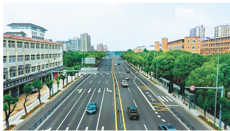
改造提升后的天童南路(绕城高速—环镇路)。(陈坦 史久阳 摄)
