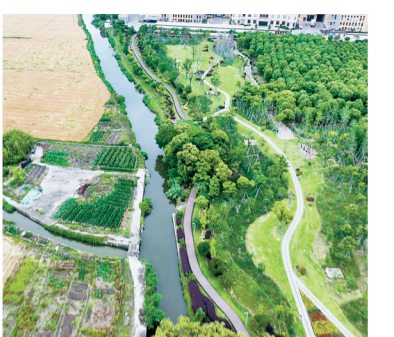
榭村港配套河道工程
