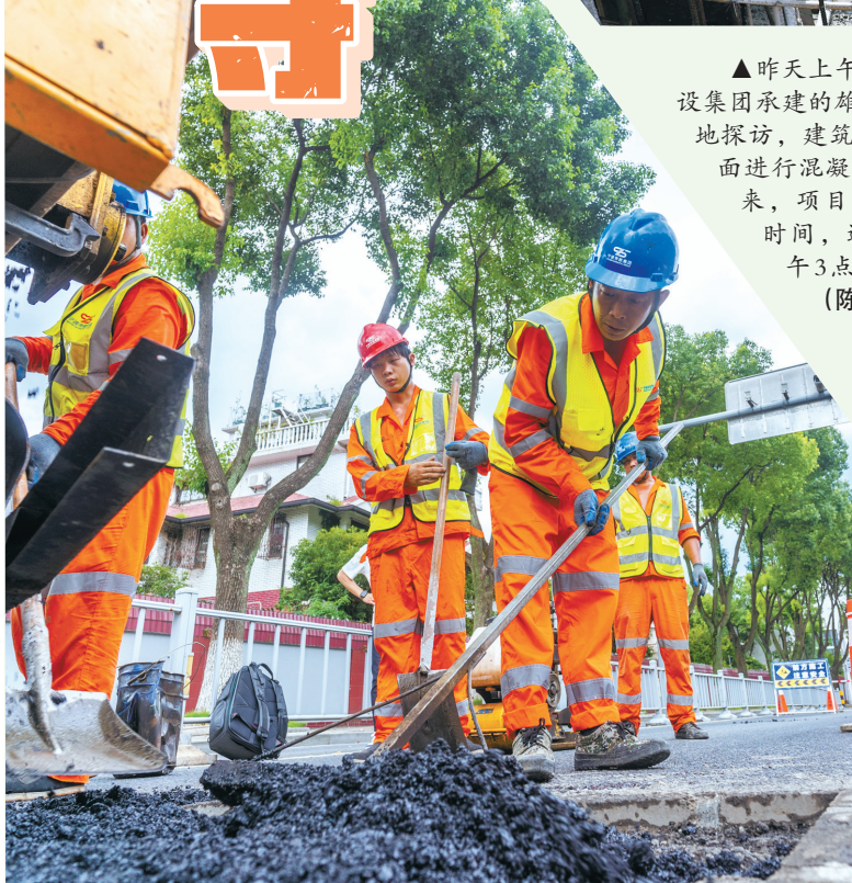
▲前天下午，骄阳似火，海曙區市政管護工人趁着天晴，抓緊對新興路上的病害進行瀝青修復。近200°C的熱瀝青本就炎熱的氣溫加劇，雖然汗水幾分鐘就浸濕了工人們的衣衫，但大家仍加緊施工，保障市民出行安全。（徐能 忻之承 攝）
