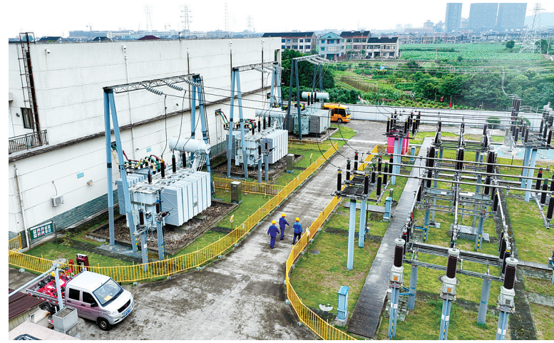
110千伏卫前变电站3号主变扩建工程建设现场。(王幕宾 摄)
