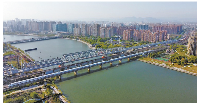
余姚江特大桥。
