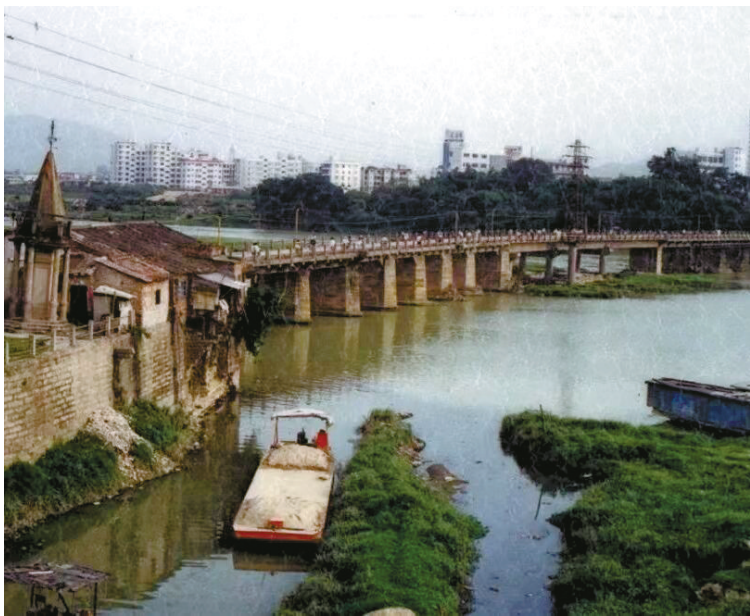
上世纪80年代末的漳州中山桥，左侧为桥亭(资料照片)
