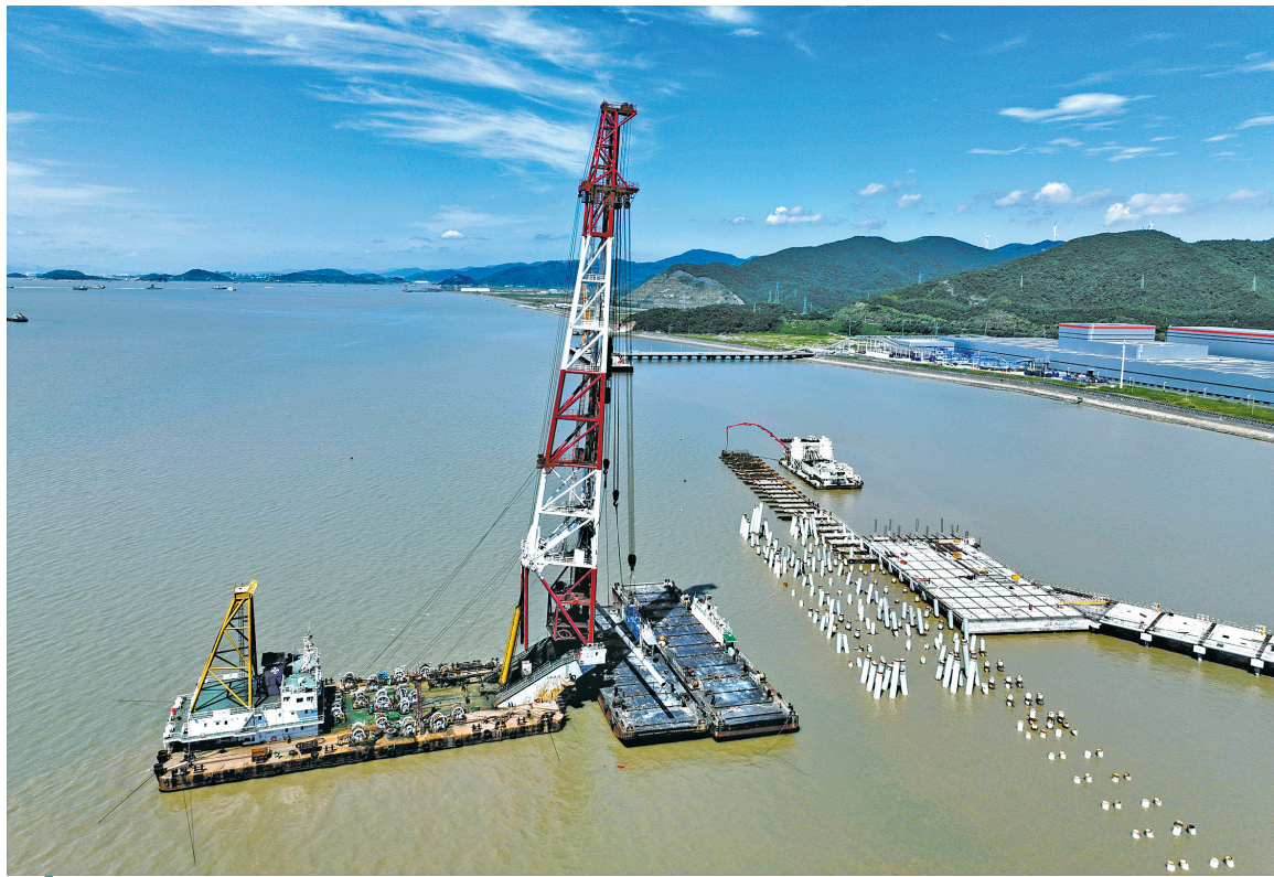
项目作业现场。
