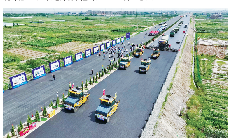
路面施工现场。
