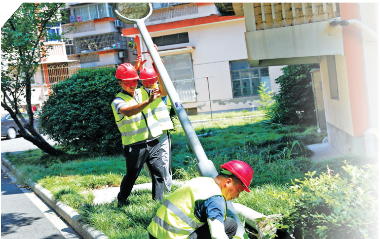
照明工人顶着烈日更换路灯。
