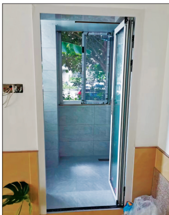
窗户改成门，外拓出一个卫生间。(石景 摄)
