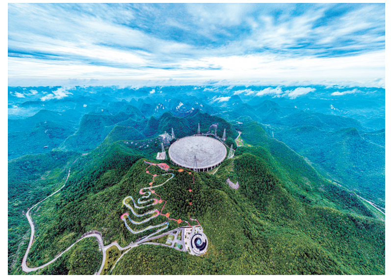
6月23日拍摄的“中国天眼”全景（无人机照片）。
