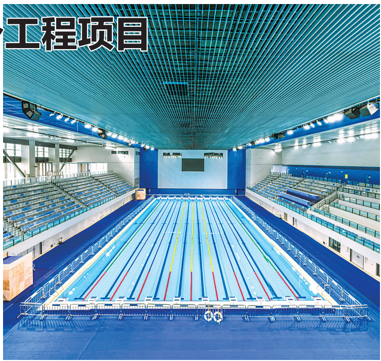
右图:宁波大丰承建的东安湖体育公园5千座的游泳跳水馆项目。(受访单位供图)
