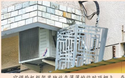
空调外机框架单独放在薄薄的临时顶棚上,存在随时掉落的风险。
