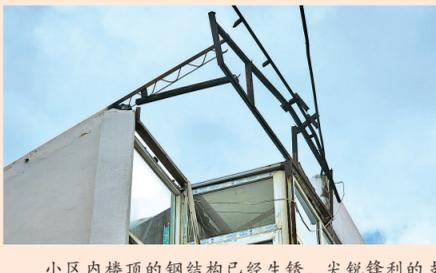
小区内楼顶的钢结构已经生锈,尖锐锋利的支架触目惊心,倘若掉落,后果不堪设想。
