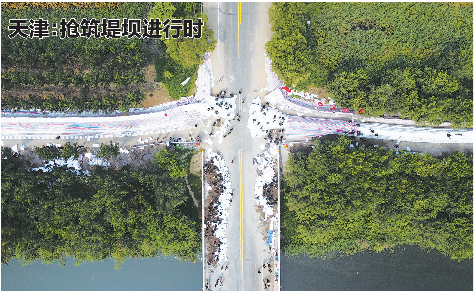
8月10日，武警第一机动总队某支队官兵在大清河支梁桥处抢筑堤坝（无人机照片）。在天津市静海区王口镇千里堤、苗头排干西堤加固抢险一线，武警第一机动总队官兵争分夺秒加固涉险堤坝，切实维护群众生命安全。（新华社记者 赵子硕 摄）
