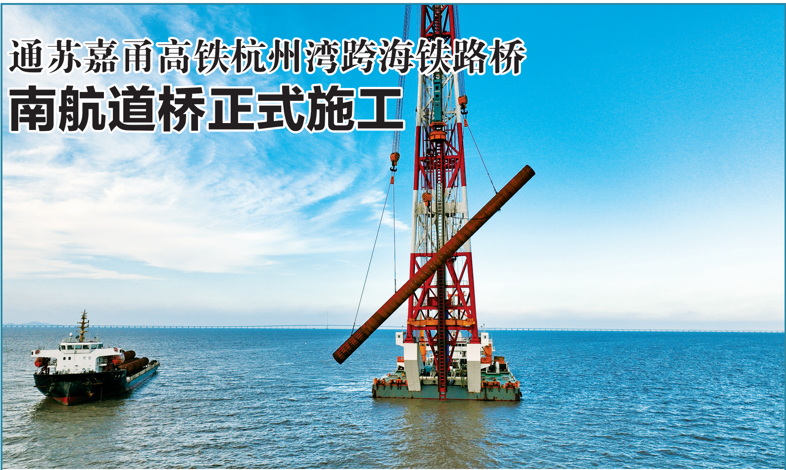
“水欣麒1”打桩船将61.1米长钢护筒吊装沉放到海中设计位置。（虞昌胜 徐能 摄）
