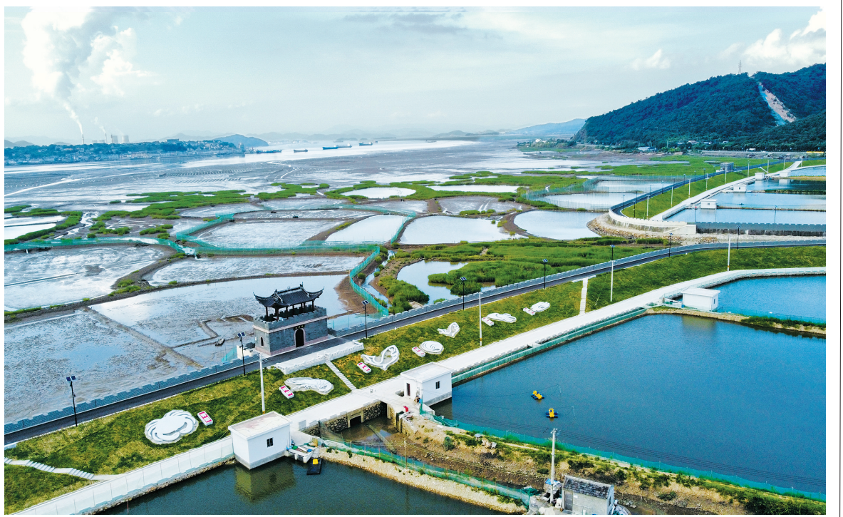
宁海全线筑起海塘。(宁海县治水办供图)
