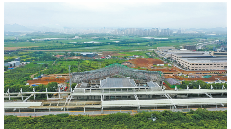
铁路奉化站扩建站房主体结构完工。
