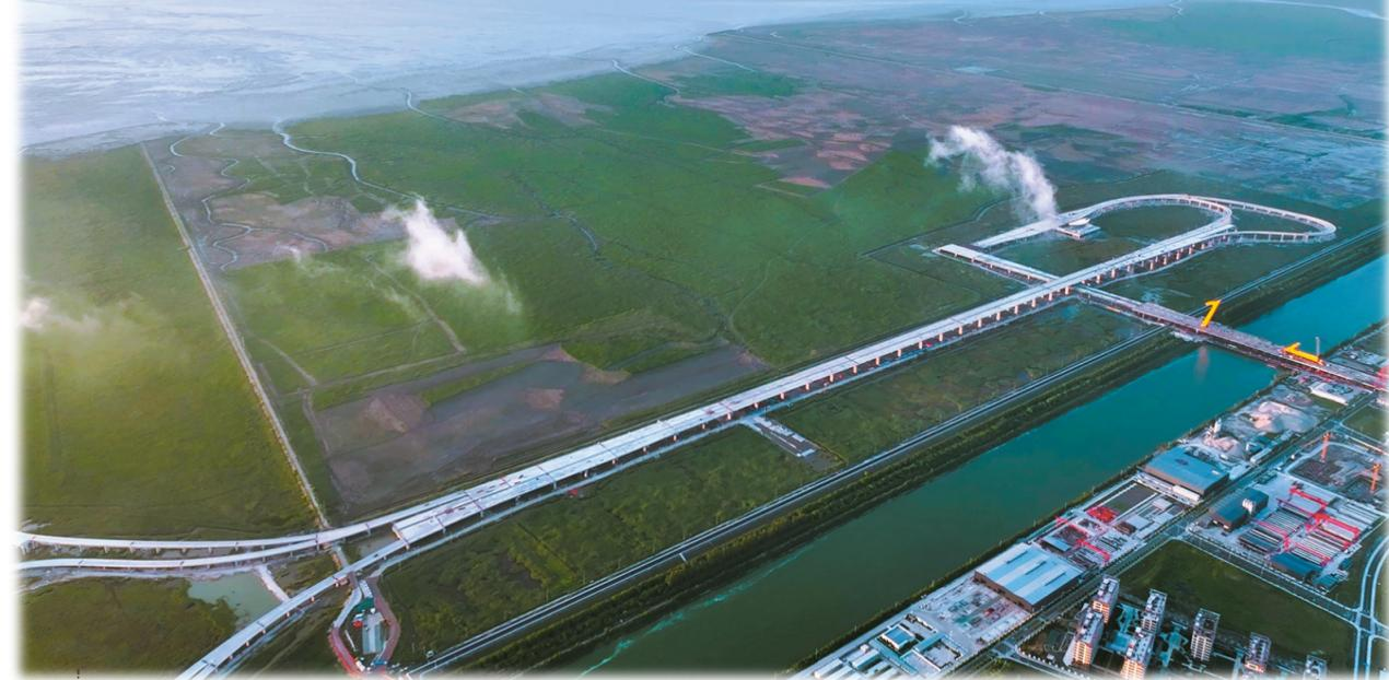
近日,记者走访时发现,宁波前湾新区“北门户”——十一塘高速公路一期建设已处于最后的冲刺攻坚阶段。当前,该工程正进行桥面铺装层、混凝土护栏和钢护栏、综合管理用房和收费大棚钢结构、拼宽桥等施工,累计完成形象进度98%,力争年底通车。
