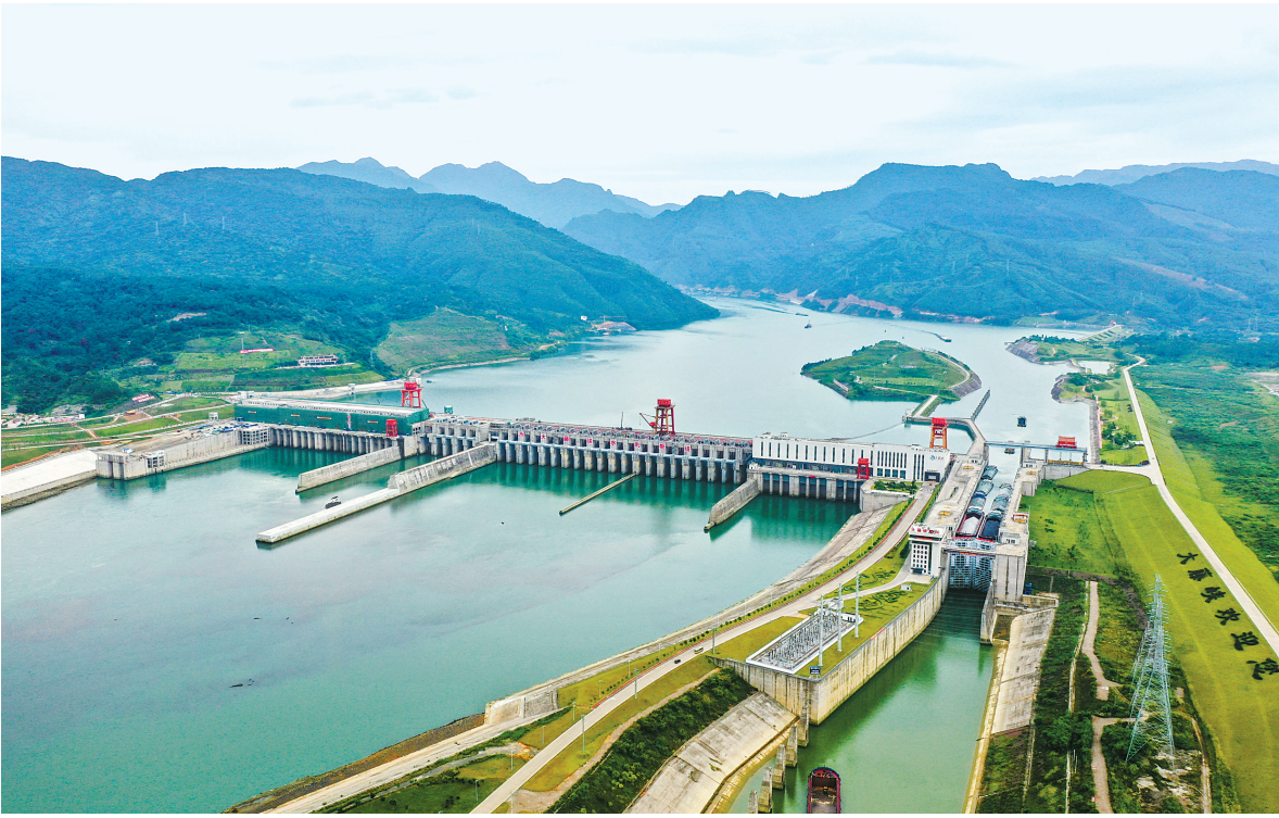
9月2日拍摄的广西大藤峡水利枢纽（无人机照片）。（新华社发）
