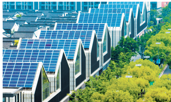
湾底村屋顶光伏发电。（徐庭娟 陆乐 摄）
