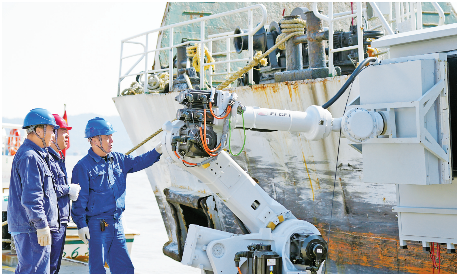
电力人员为船舶进行无线充电。
