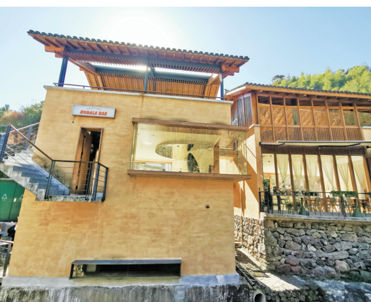
栖霞坑村闲置的水电站变身咖啡馆。（孙吉晶 摄）
