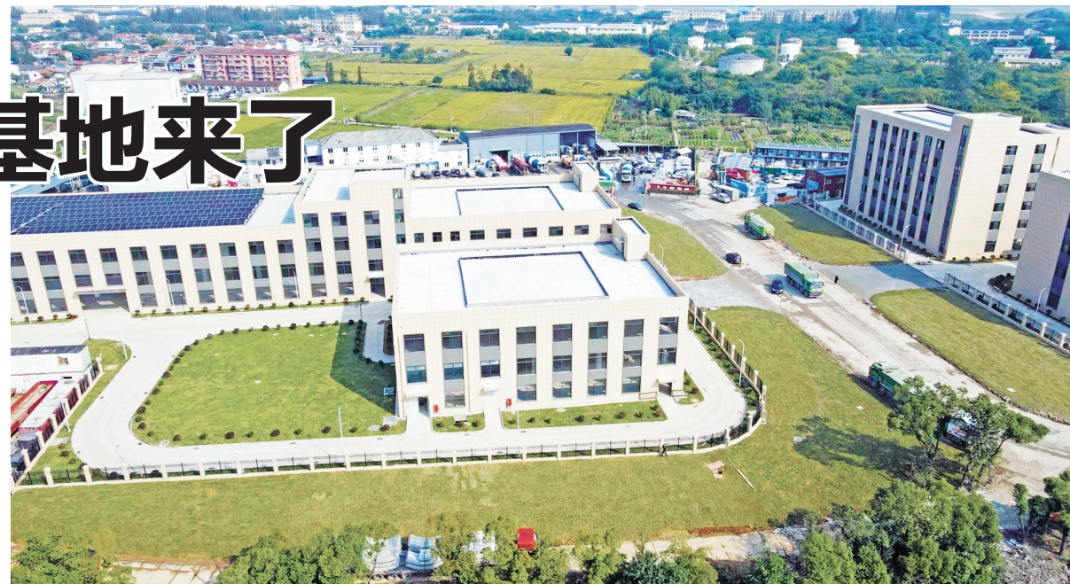
宁波建筑服务产业园2.0基地。
