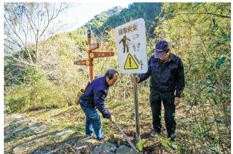
昨日，工作人员来到海曙区龙观乡龙溪村的山间步道，安装“注意安全”指示牌。龙观乡青山环绕，但因山间地势复杂，“驴友”在山中迷路的情况时有发生。为此，龙观乡在一些关键路口安装了指示牌，以保障游客安全。(徐能 忻之承 摄)
