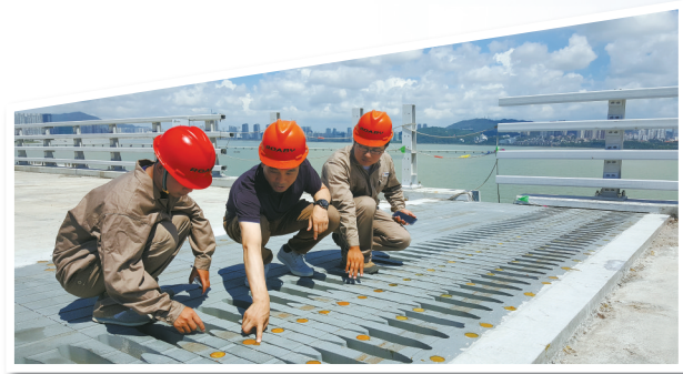
工程人员在检查桥梁变位装置。 (企业供图)
